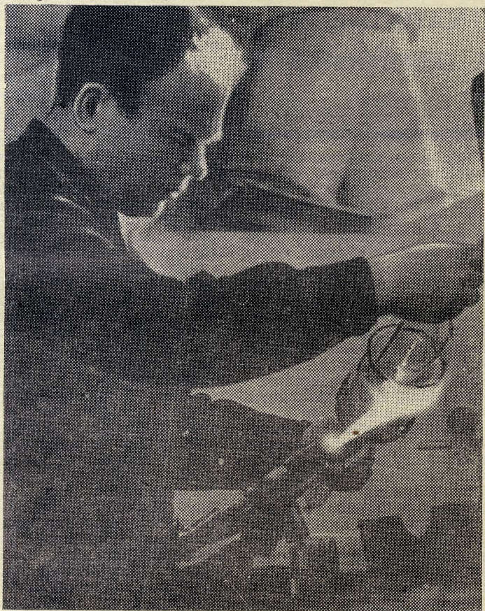
Иван Васильевич Еремеев работает стеклодувом более 10 лет. Ему поручают делать самые хитроумные вещи. Сейчас он сооружает дыаровскую ловушку для жидкого азота.
