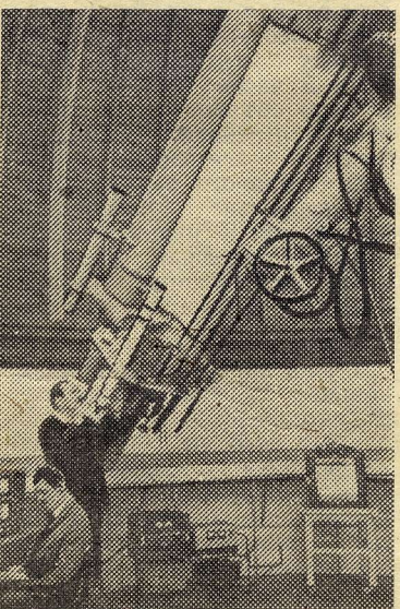
Абастуманская астрофизическая обсерватория АН ГССР. 40-сантиметровый рефрактор в комбинации с поляровизором изучаются поляризационные свойства поверхности Луны и планет.
