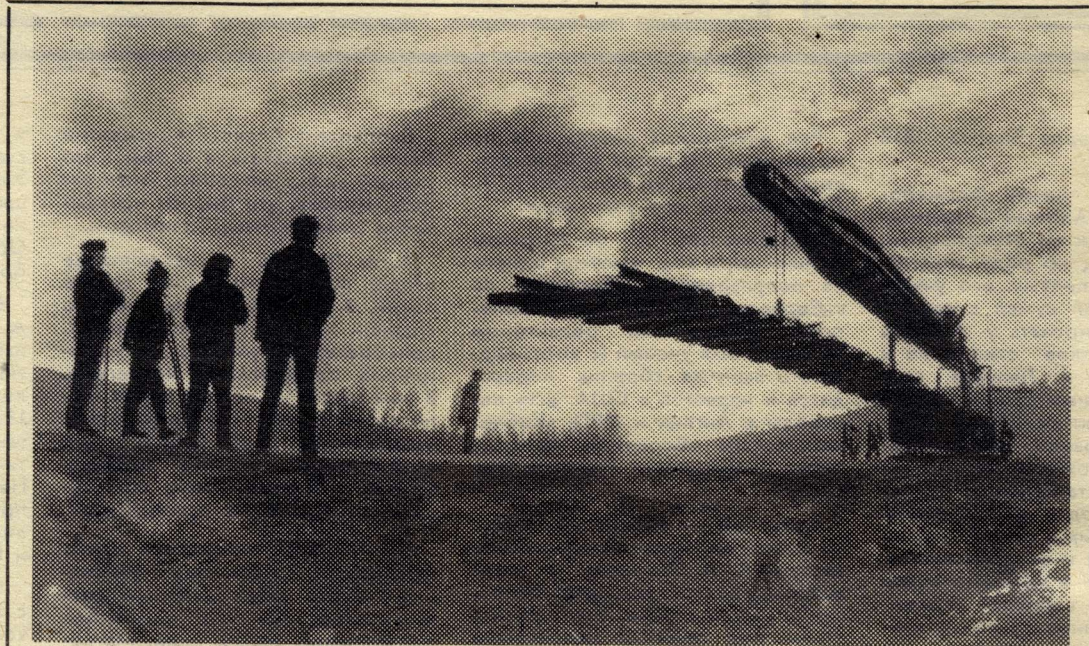
Укладка полотна на одном из участков Байкало-Амурской магистрали.
