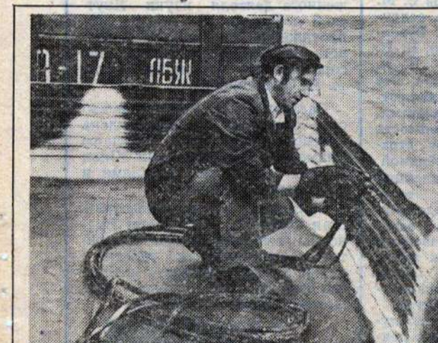
Алтайский край, Целинный район. Герметизация кузовов автомашин, предназначенных для перевозки зерна. Стесарь И. В. Андрианов обрабатывает леной кузов. На одну машину уходит 10—15 минут.
