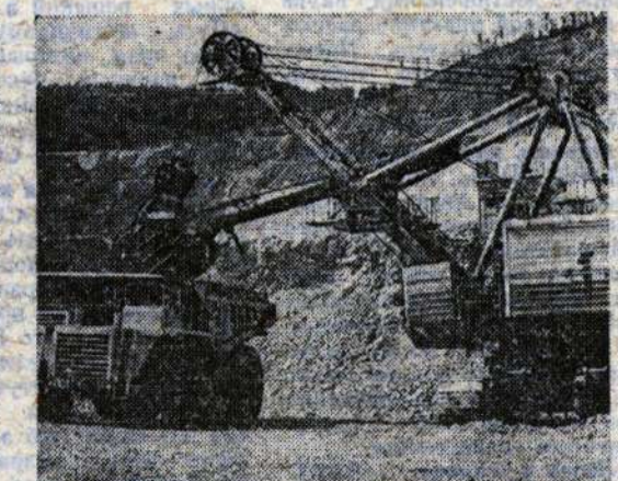
Сорский молибденовый комбинат. На горных работах с наилучшими в отрасли показателями эксплуатируется парк автосамосвалов особо большой грузоподъемности (110 тонн).
