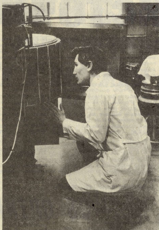
Интересные результаты в формировании систем диэлектрик-полупроводник получены при активации реакций мощным световым излучением. На снимке: инженер С. Шурховецкий у работающей установки, созданной им.
