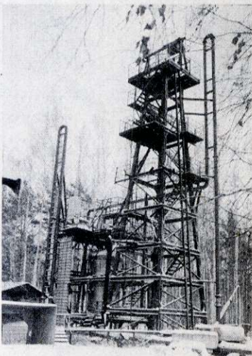
На снимке: опытный стенд импульсного пневмотранспорта.
